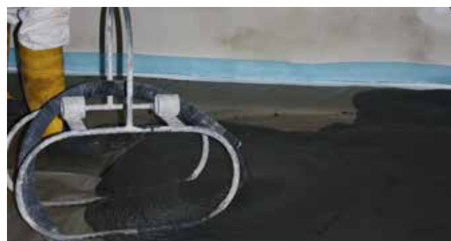
RÖFIX ArtFloor wird mittels Maschinenteknik eingebracht
