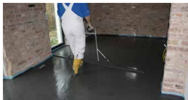
RÖFIX ArtFloor mittels Schwabbelstange nivellieren
