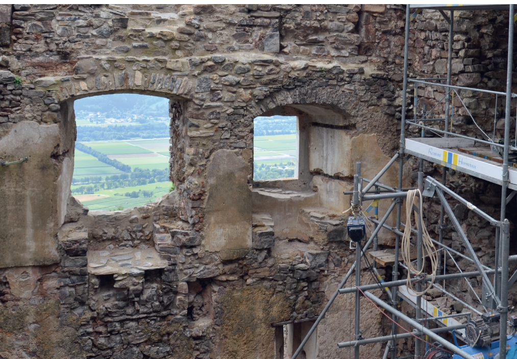
Gute Lage: Blick durch Ruinenfenster ins Rheintal.
