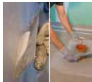
Auftragen der ersten Schicht und Einlegen von Dichtbändern/ Dichtmanschetten
